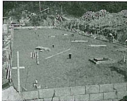
Fig. 4. Byggegrøp ferdig gruset.
