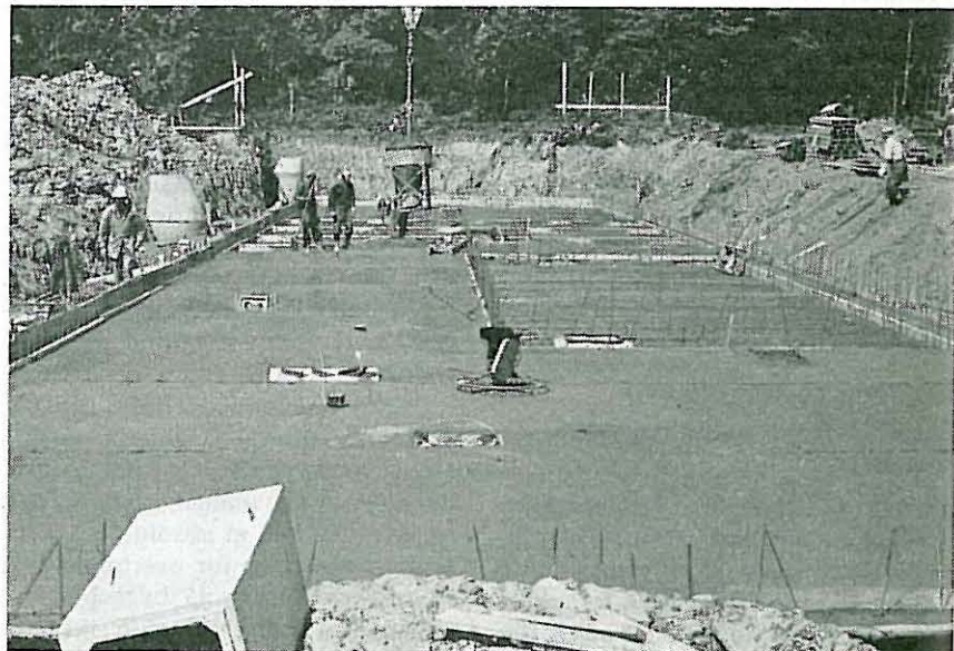
Fig. 5. Bunnplate. Lirer kun under veggene.
