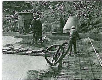
Fig. 6. Utstøping av bunnplate.
