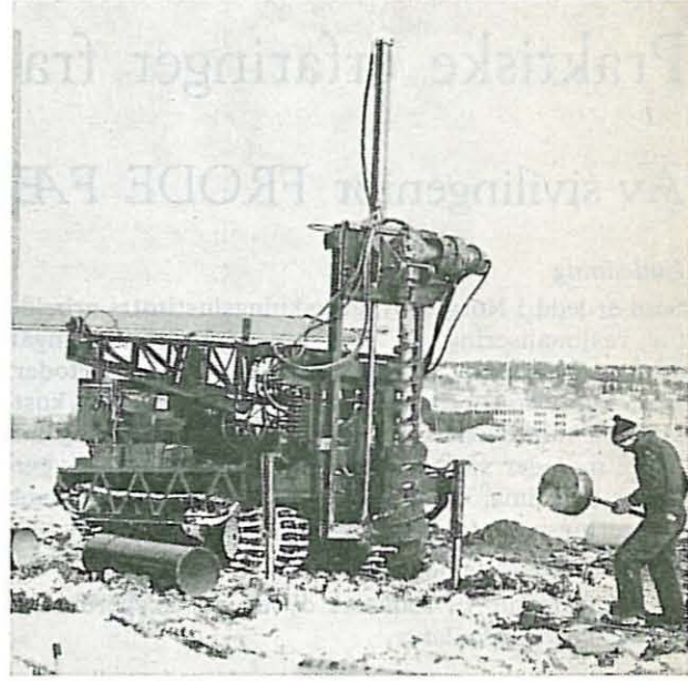
Fig. 3. Muskeg snetraktor med borerigg. Bemerk redskap for rensk av hullbunn.
