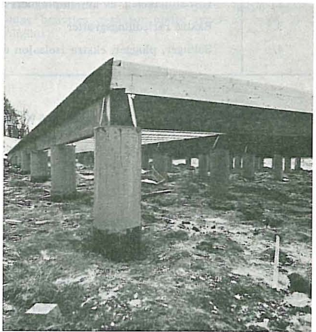
Fig. 5. Ferdige pæler med bjelkelag.
