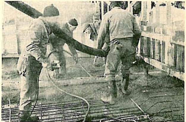
Fig. 7. Fleksibel slange ved rørenden
