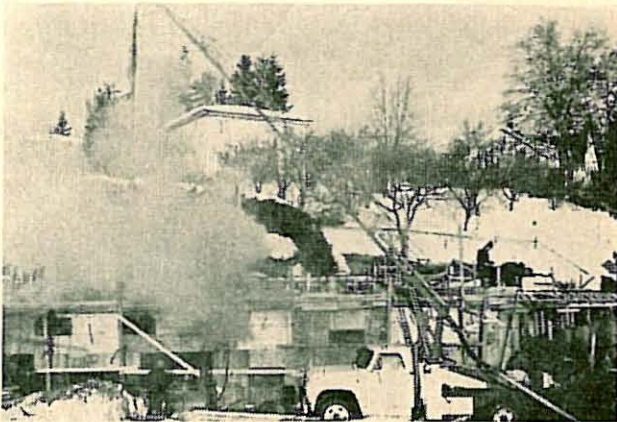
Fig. 14. Betongstøping ved hjelp av mobil betongpumpe og utligger (Thomsen Equipment)
