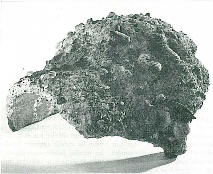
Fig. 1. Betongrør, ca. 8 år gammelt med utvendige skader på grunn av kullsyreangrep.
