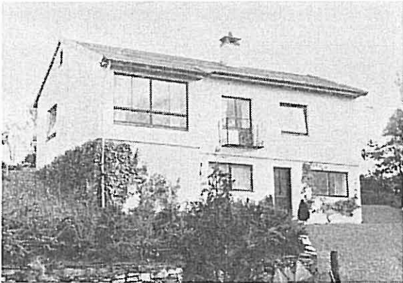
Avstanden fra terreng til vinduene kan bli ganske stor selv i forholdsvis små hus. Skrånende terreng og beplantning kan vanskeliggjøre pussarbeidet ytterligere.
