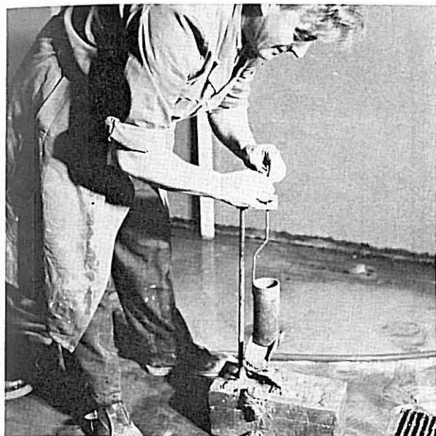
Fig. 2. Bestemmelse av mørtelens stivhet (konsistens) ved hjelp av Mo-måler.
