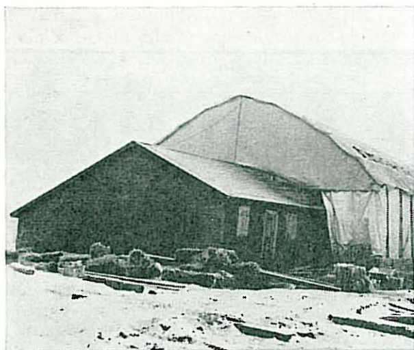
Fig. 1. Bygging under fullt telt.
