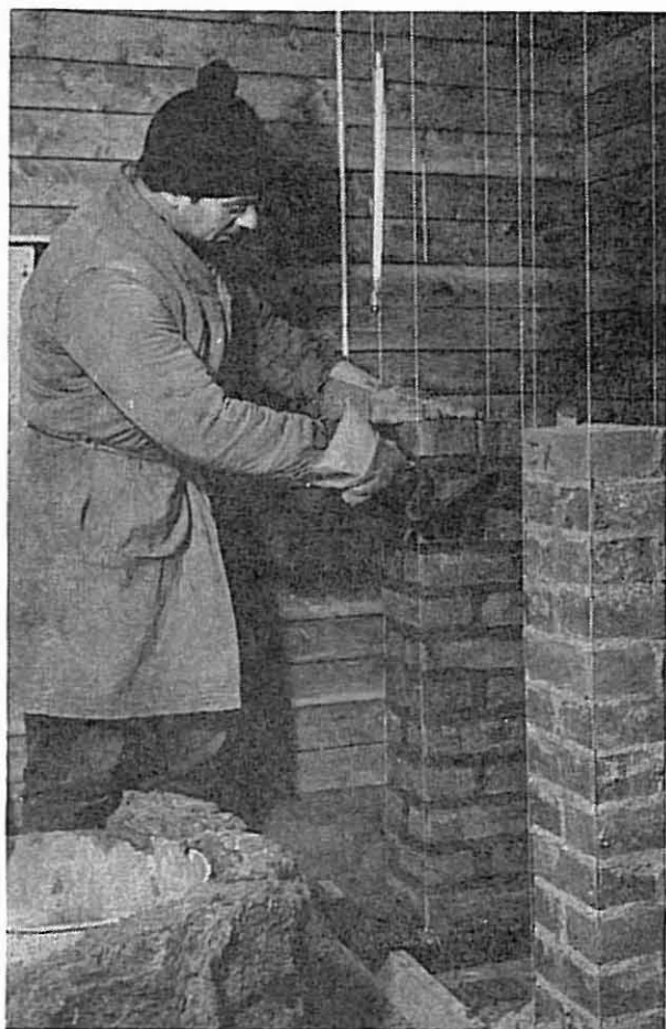
Fig. 5. Muring av pilarer i kjølerom.
