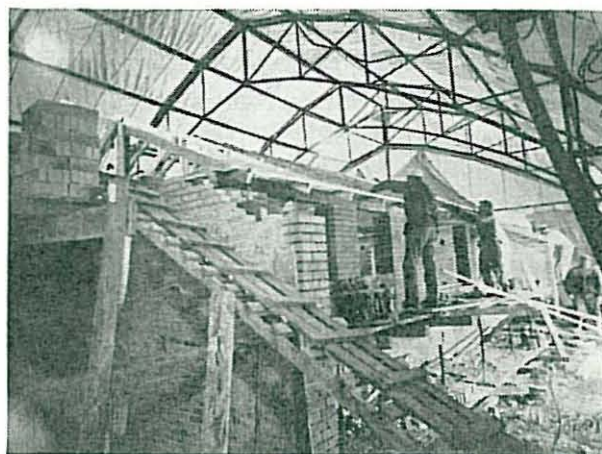
Fig. 2. Bygging under fullt telt.
