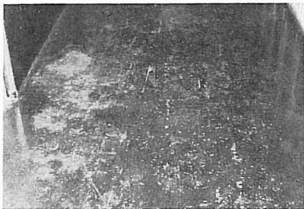
Fig. 3. Sånn foregår slitasje. En mann som stanser, snur seg og åpner en dør, gir mer slitasje enn flere hundre som går rett frem.
