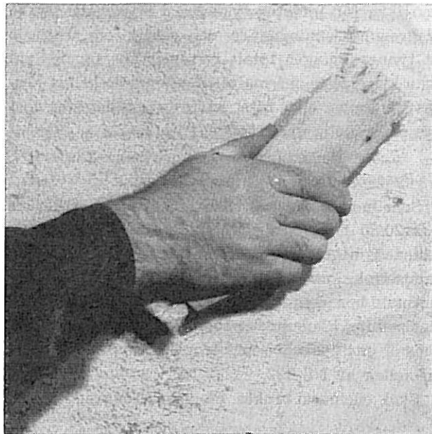
Fig. 1. Børsting av underlaget.
