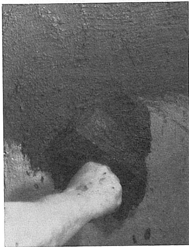
Fig. 3. Tynngrunning med kost.
