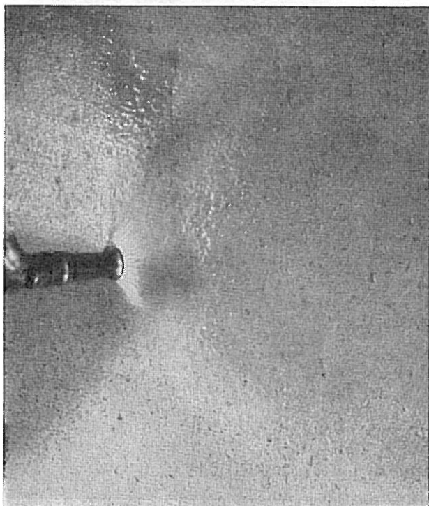
Fig. 2. Fukting av underlaget.
