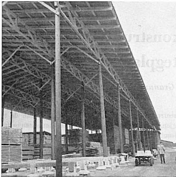
Fig. 3 a. Tak over trelastlager.
