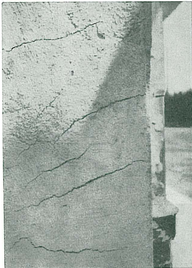
Fig. 15. Sigeriss som senere er blitt sterkt utvidet p.g.a. svinn i mørtelen.
