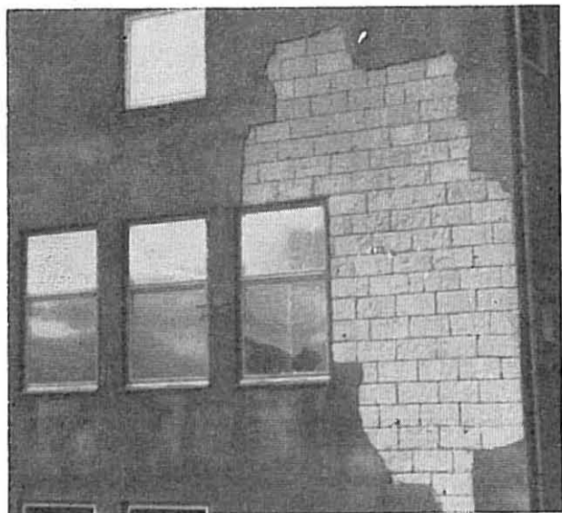
Fig. 9. Et resultat av alt for sterk mørtel på relativt svakt underlag.
