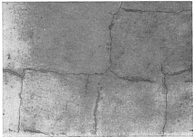
Fig. 7. Karakteristiske fugeriss rundt blokker.
