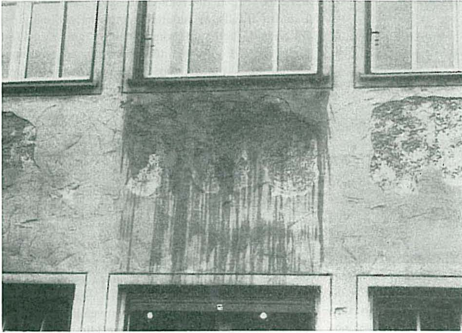
Fig. 26. Frostskadene under vindu skyldes delvis at sølbenken ikke er gitt stort nok utstikk.
