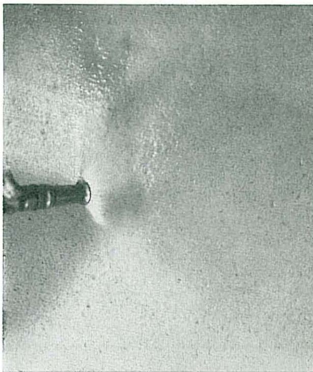
Fig. 34. Fukting av underlaget.
