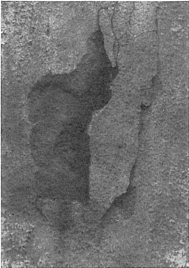
Fig. 11. Her skyldes sprekningen en avstandskloss av tre.
