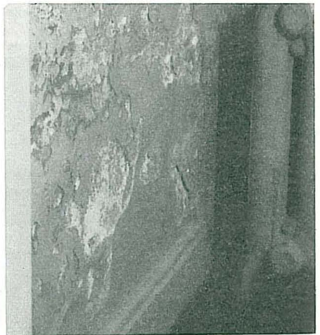
Fig. 28. Innvendige saltskader.
