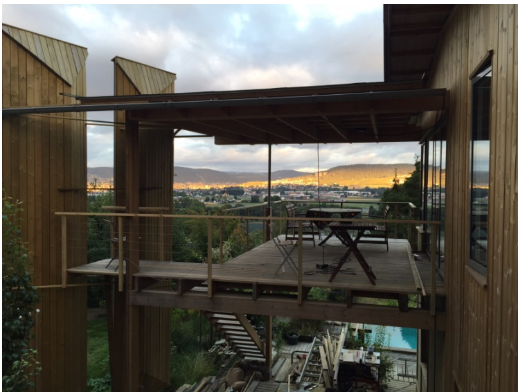
Solfangerne utgjør i seg selv arkitektoniske elementer i ombyggingen, er feste for solseil for skygge på varme dager og beskyttelse mot vind og vær, noe som forlenger sesongen, og øker brukbarheten av terrassen.
