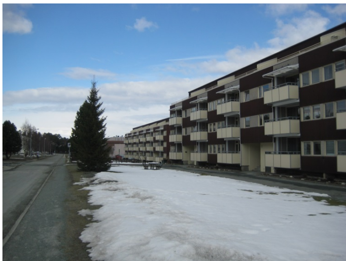
Fasader mot vest før og etter rehabilitering
