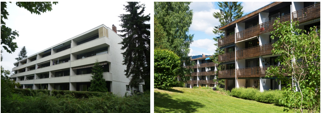
Eksteriørbilder før og etter rehabilitering. Foto: Espen Grønli.
