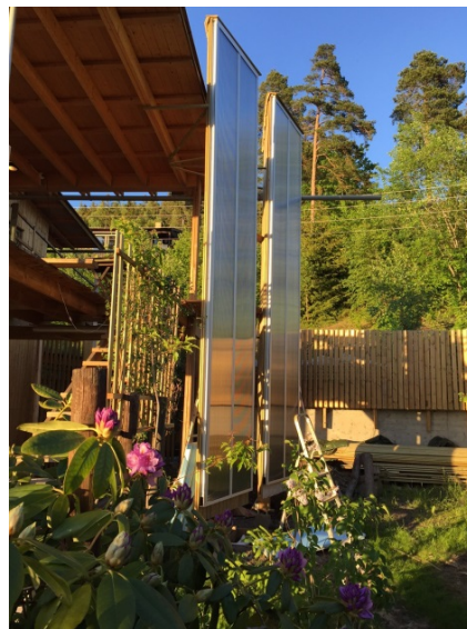
Solfangerne utgjør i seg selv arkitektoniske elementer i ombyggingen, er feste for solseil for skygge på varme dager og beskyttelse mot vind og vær, noe som forlenger sesongen, og øker brukbarheten av terrassen.
