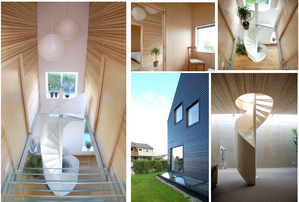
Fra tilbygget mot nord: En ny spindeltrapp forbinder etasjene. Dagslys taes ned i underetasjen både via spindeltrappen og en skylight som sildrer dagslyset ned langs betongveggen.
