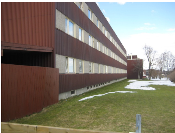
Fasader mot øst før og etter rehabilitering
