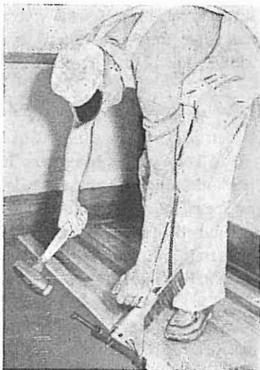
Fig. 14. Hjelpemiddel ved spikring av golvbord.
