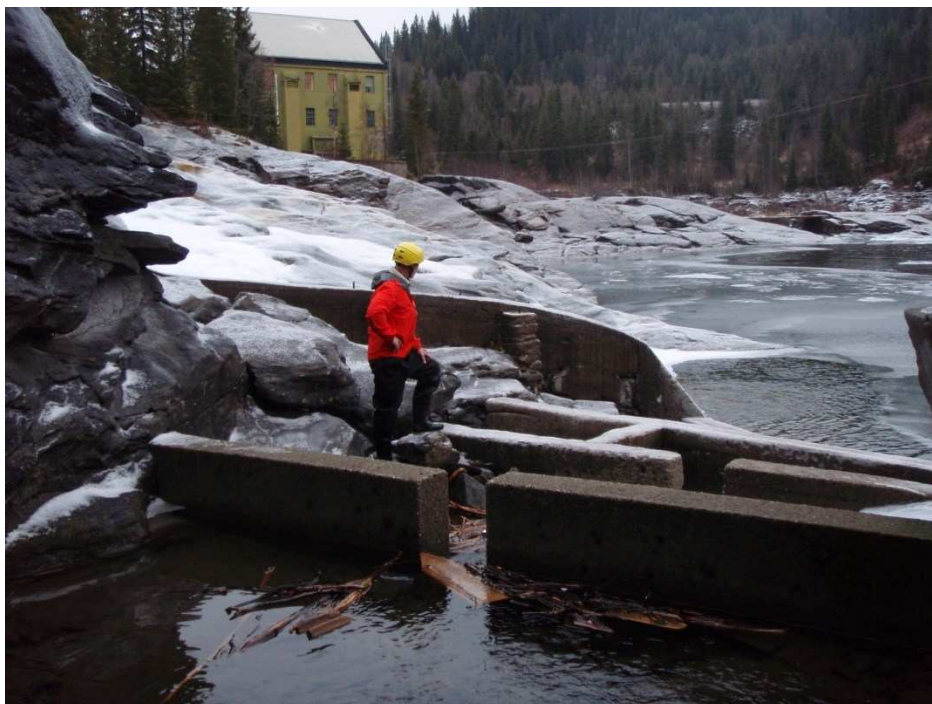
Figur 3. Støttmuren mot fossen, inngangen og de nederste kulpene (1-4) i trappa i Reinforsen. Reinforsen kraftverk kan ses på motsatt side av fossen, som på bildet er tørrlagt.
