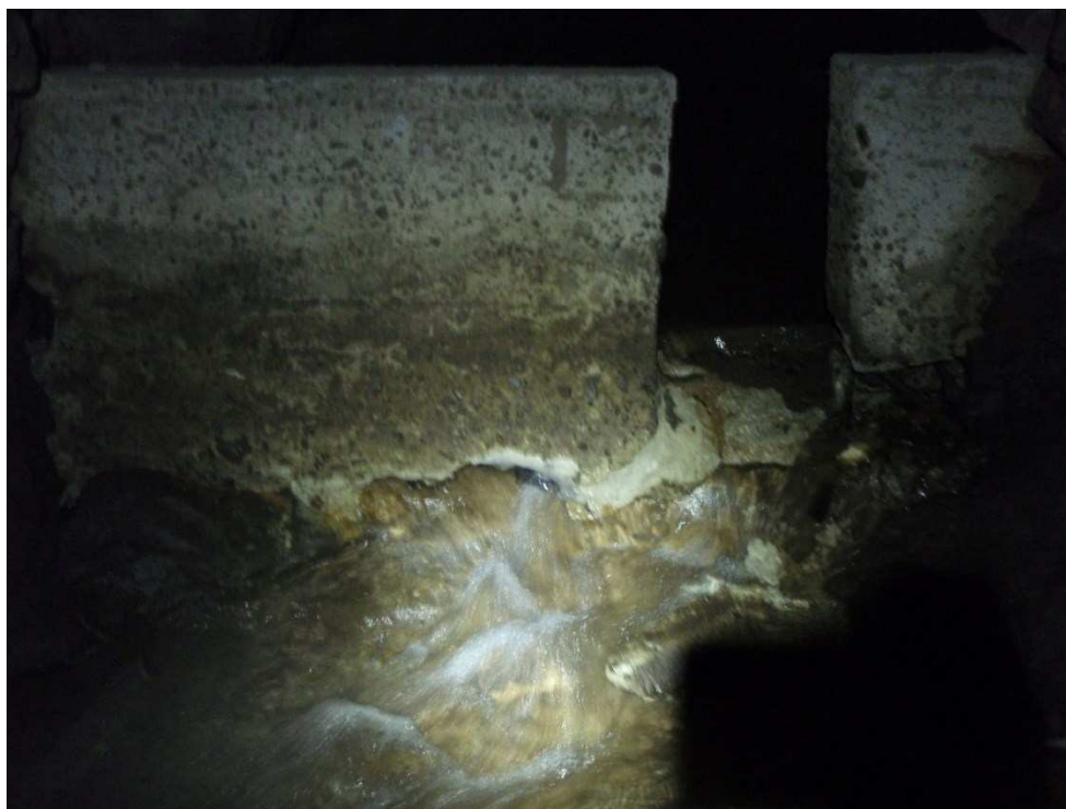
Figur 5. Terskel 17, eksempel på en terskel som vurderes som ødelagt.
