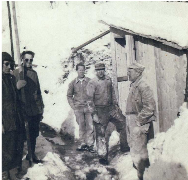
Bygging av Laksetrapp i Reinforsen på 1950-tallet. Fotograf: Ukjent
