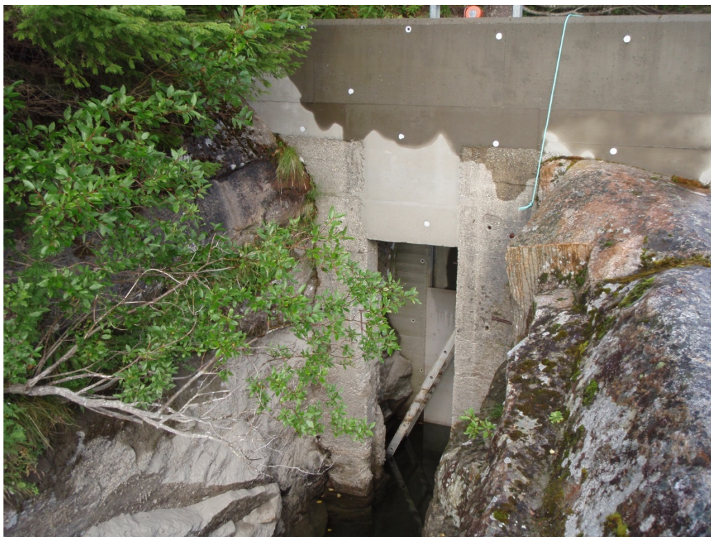
Figur 5. Ny inntaksluke for vann i trappa i Laksfors.
