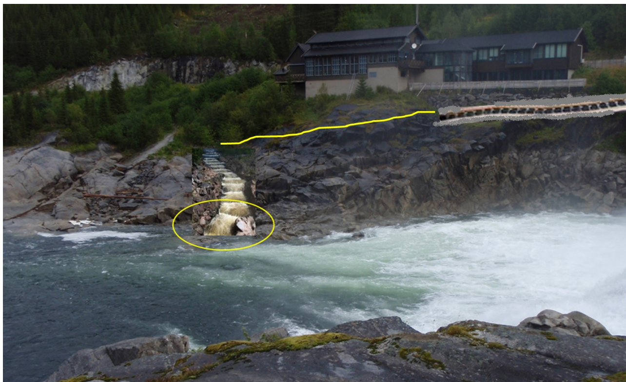
Figur 14. Foreslått plassering av inngang (gul sirkel) og videre trappetrase, indikert med vekselvis åpen trapp og tunnel (gul strek), for ny trapp på østsiden av Laksfors.
