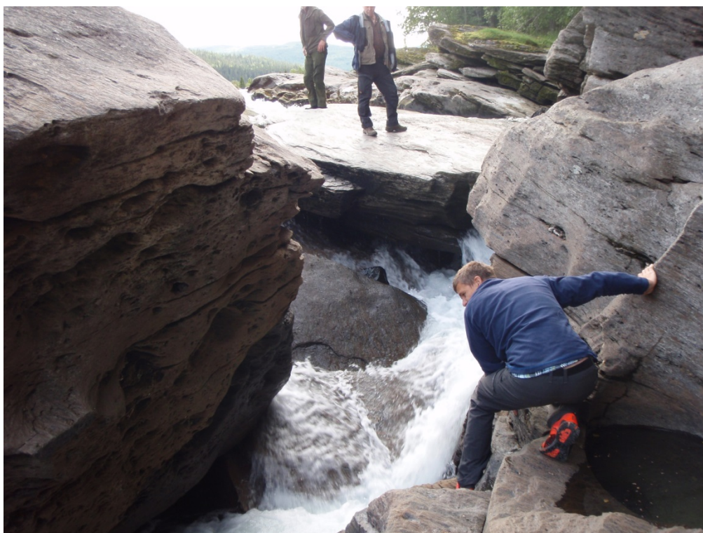
Figur 11. En stor helle/steinblokk på mange tonn har lagt seg midt i den øvre delen av "laksetrappa" i Mikkelfjordfors.
