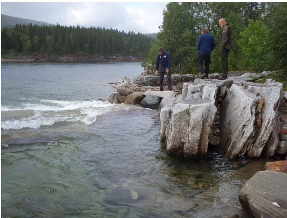
Figur 8. Utgangen av trappa på østre side av Fellingfors. Utgangen befinner seg under steinene ved personen til venstre i bildet.
