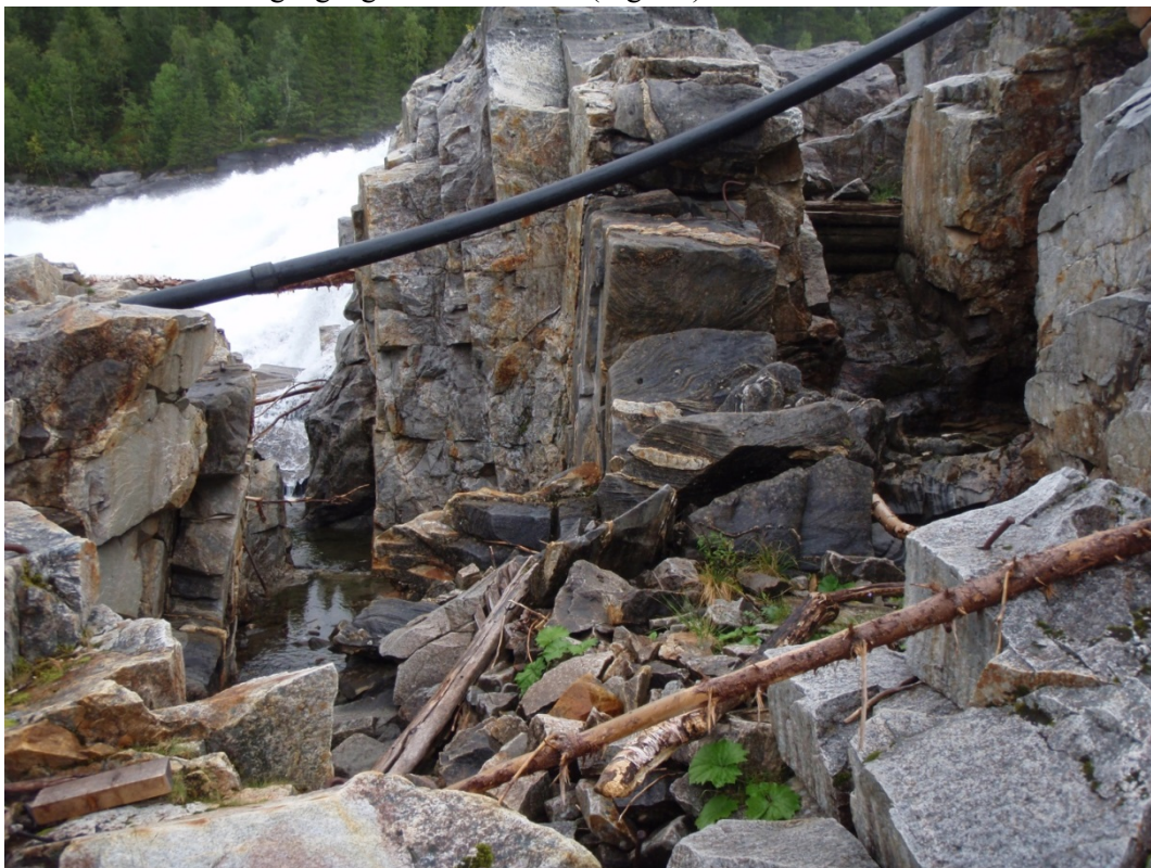
Figur 6. Steinura midt i bildet, samt berget bakenfor er i ferd med å skli ut i fisketrappa, som vises i bildets venstre side.
