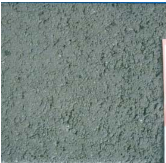
Figur 2 Nylagt Ska8-dekke, august 2005
