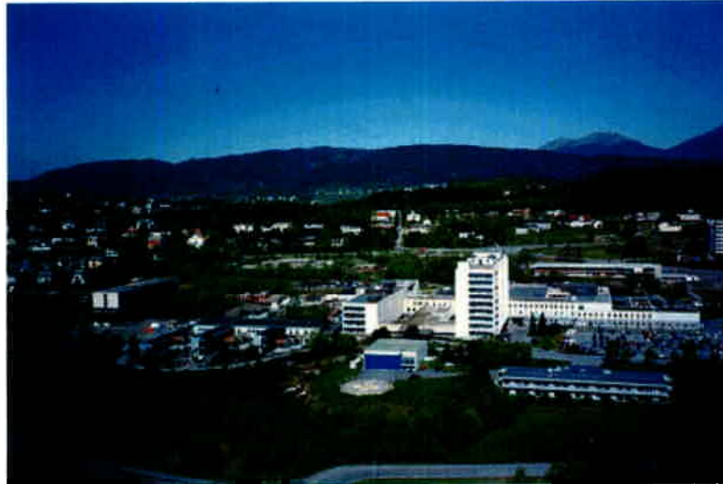
Figur 3-1 Oversiktsbilde over Ålesund sjukehus.
