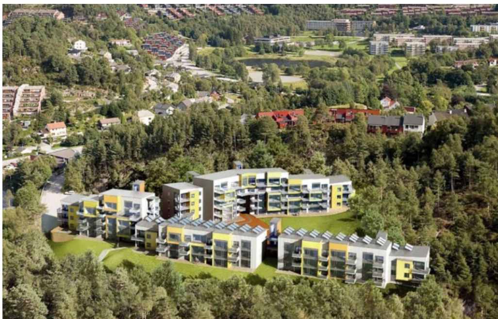
Figur 3.5 Løvåshagen med passivhusblokker i front og lavenergiblokker til venstre, Illustrasjon: MIR.
