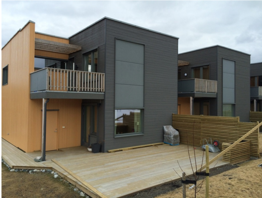
Figur 3.4 Fasade mot sør som viser avsatt plass for solfangere for eneboligene.
