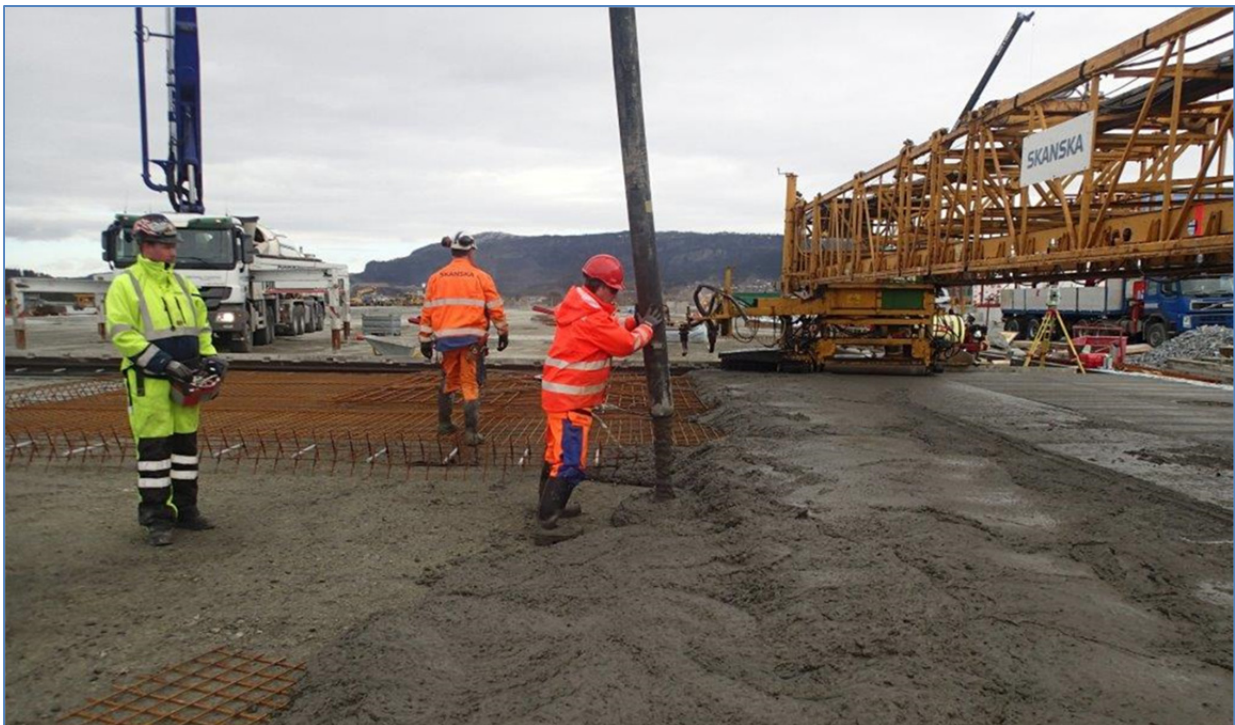
Figur 2. Fordeling av betong med pumpe (Foto: Gunrid Kjellmark, SINTEF Byggforsk)
