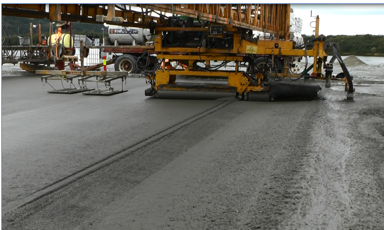
Figur 3. Komprimering, avretting, valsing og glatting med Bidwell utlegger. Slepevibratorene er synlige helt til høyre på bildet (Foto: Gunrid Kjellmark, SINTEF Byggforsk)
