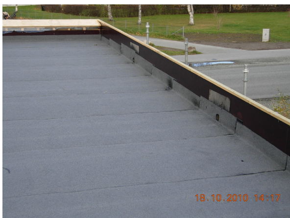
Fig 2.10 Takflaten ferdig tekket; det som gjenstod var inntekking av oppkantene, ferdigstilling av parapetene og beslagsarbeidene.
