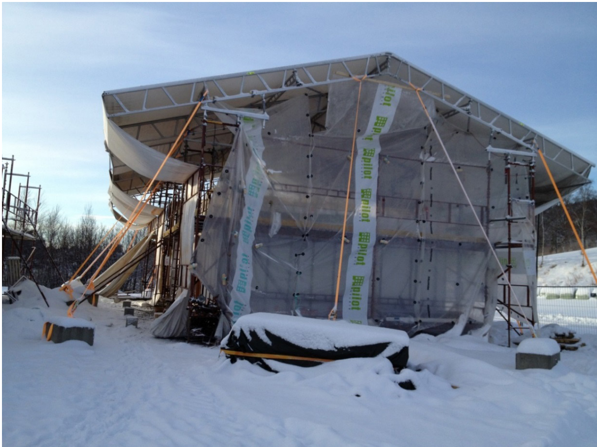
Bygging under telt 06.02.2013, foto Ruth Woods
