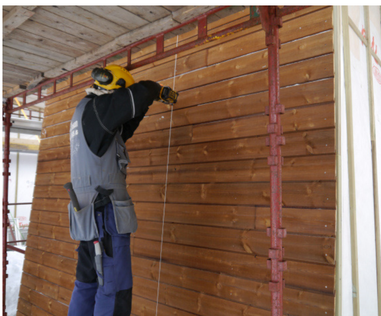
Montering av kebony på fasaden, 14.02.2013, kilde Vassneset blogg
