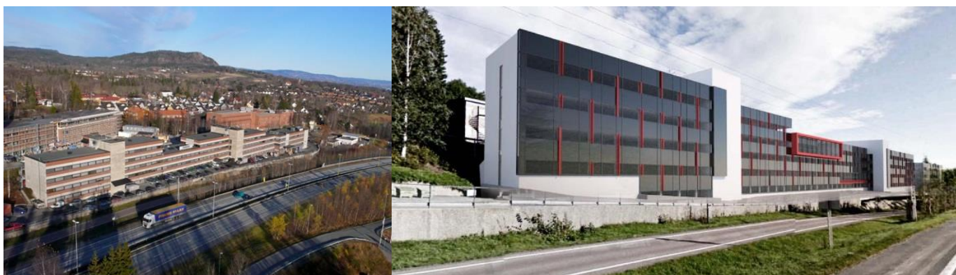
Figur 1.2 Solbråveien 23 før og etter oppgradering
