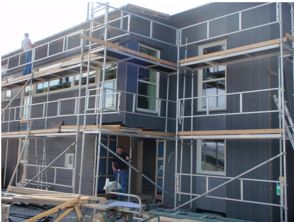
Figur 18: Fasaden med vinduene på plass (Fjogstad-Hus)
