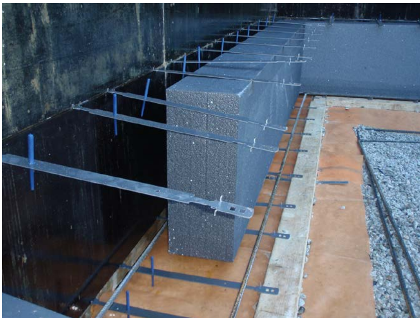
Figur 15: Grunnmur med 20 cm isolasjon (Fjogstad-Hus)
