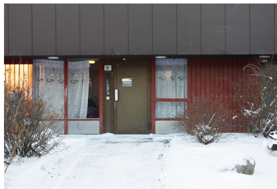
Over: Alminnelige inngangsdør. inngangsparti i borettslaget. Noe overdekking, men denne beskytter ikke mot snø. Belysning i taket under overdekkingen. Ved oppgradering bør det i tillegg være belysning over tablået til porttelefonen eller callinganlegget bør ha innvendig belysning. Når tablået byttes, må den nye være tilgjengelig for personer med ulik størrelse/sittende i rullestol.
