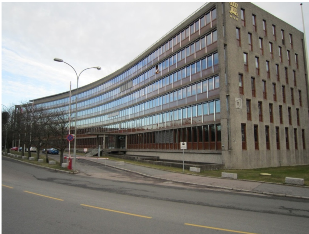
Figur 3.3 a Rehabiliteret fasade i NVE-bygget. Etasjeskiller i betong kommer til syne utvendig på fasaden. Kilde: UPGRADE Solutions
