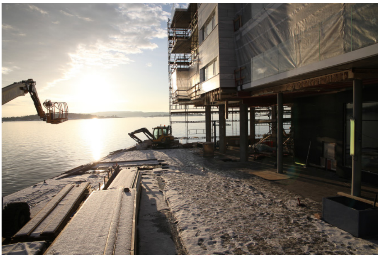
Foto: Det er viktig å starte planleggingen med tanke på ombruk på et tidlig tidspunkt som en del av prosjekteringsfasen. (Foto: Mette Langeid, SINTEF Byggforsk)
