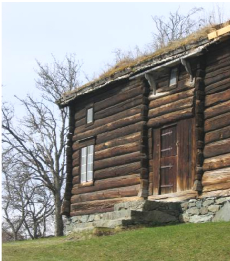
Foto: Tradisjonell laftekonstruksjon; tilrettelagt for utskifting av stokker, om- og påbygging samt flytting av hele hus. Fra Sverresborg folkemuseum
