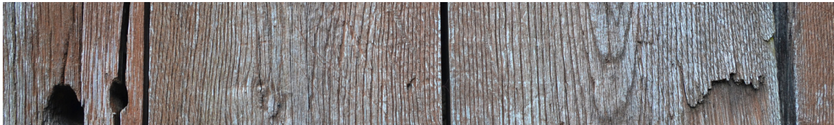
Foto: Trepanel på yttervegg (StockFreelimages 2014)
