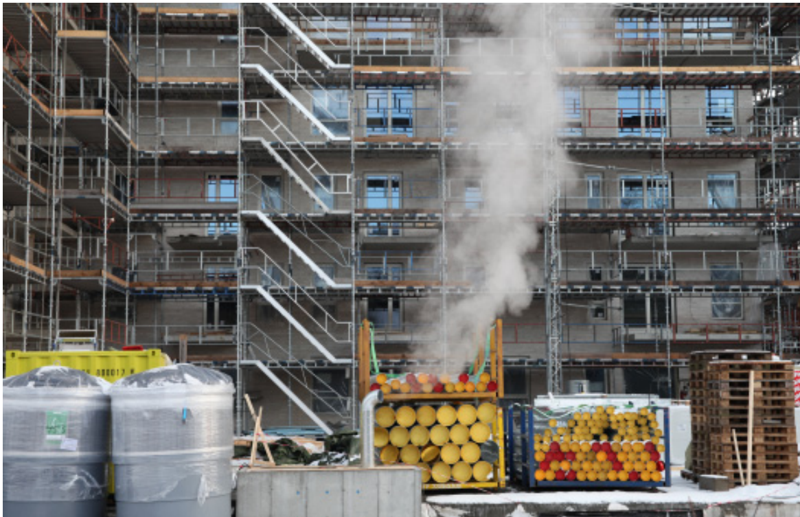
Foto: På byggeplass (Foto: Mette Langeid, SINTEF Byggforsk)
