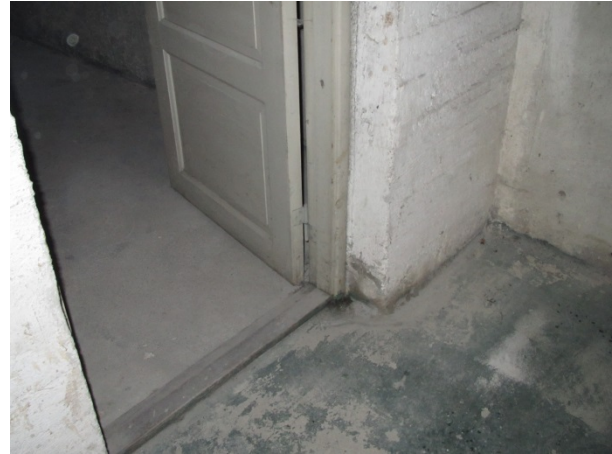
Foto 7 (SINTEF Byggforsk) Typisk detalj fra dør. Tredørene har ikke synlige tegn til å ha tatt skade fra vann i kjelleren.
