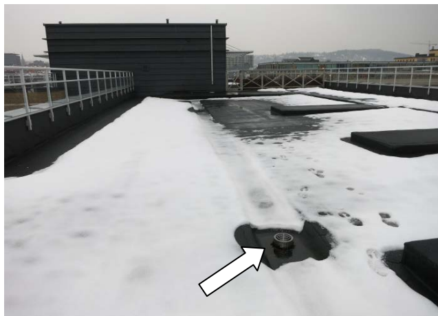
Foto 23 (SINTEF Byggforsk) Innvendig nedløp fra flatt tak
