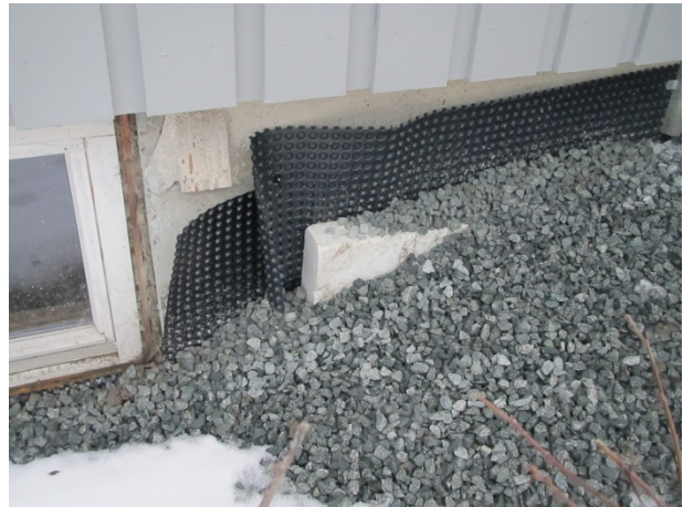
Foto 11 (SINTEF Byggforsk) Ny drenering med montering av grunnmursplater og tilbakefylling med drenerende masser.
