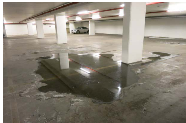
Foto 21 (SINTEF Byggforsk) Vann på garasjebolv fra avrenning fra biler og fottøy
