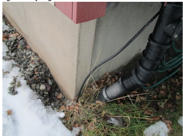
Foto 13 (SINTEF Byggforsk) Fotoet viser nedløp som er tilkoblet kommunalt overvannssystem.
