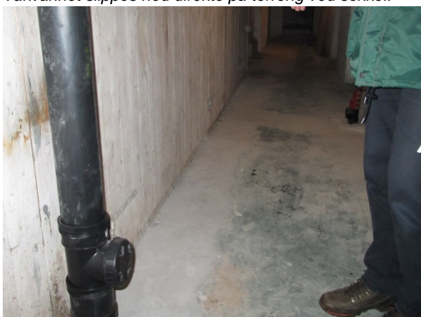
Foto 5 (SINTEF Byggforsk) Fra innvendig kjellergang midt i bygningen. Her ligger fornyet avløpsrør. Spor i golvet viser at det er gjennomført tiltak. Kjellerveggene er av støpt betong. Kjelleren har vært utsatt for vann ved flere tilfeller, men det er ikke synlige skader på vegger eller betonggolv.
