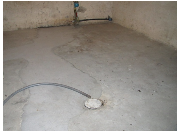
Foto 9 (SINTEF Byggforsk) Fra rom brukt som vaskerom i kjeller. Det er ingen synlige tegn til skader etter tidligere og gjentatte oppfuktninger. Det er montert nytt sluk med tilbakeslagsventil i kjellerarealene.
