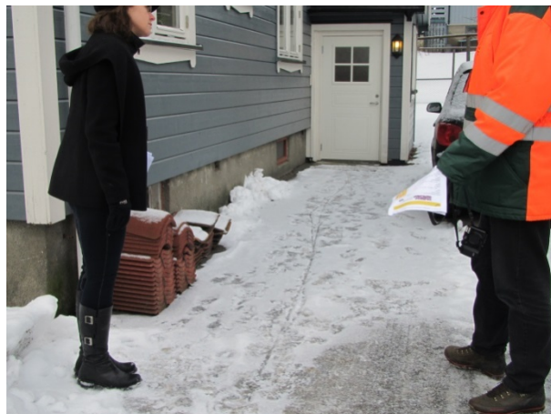
Foto 2 (SINTEF Byggforsk) Utenfor inngangsparti. Tett overflate med lite fall fra huset. Ingen fornyet drenering synlig.
